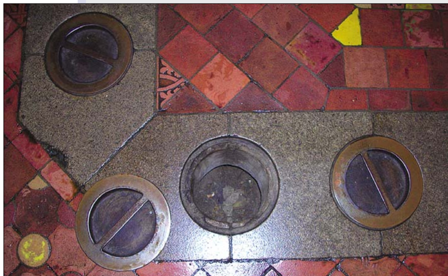
Fot. 2. Sposób regulacji ogrzewania w komnatach Zamku Krzyżackiego
