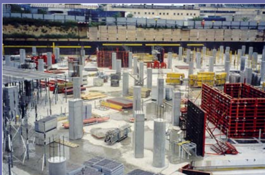
Fot. 1. Realizacja części podziemnej obiektu w wykopie zabezpieczonym ścianką berlińską kotwioną
