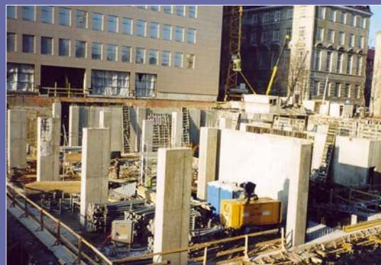
Fot. 6. Zrealizowana część podziemna budynku
