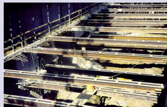
Fot. 3. Palisada rozparta o konstrukcję płyt stropów kondygnacji podziemnych obiektu
