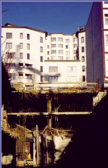
Fot. 5. Realizacja części podziemnej budynku metodą stropową
