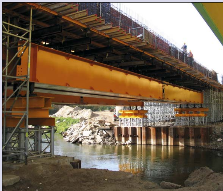
Most nad rzeką Bóbr – Droga Krajowa M-18 Fot. J. Tomczyk: archiwum ULMA Construction Polska S.A.
