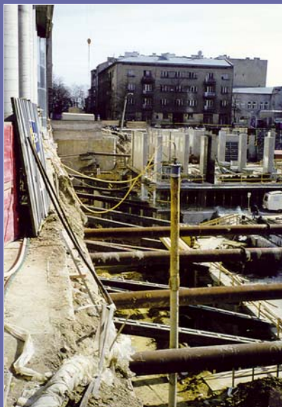
Fot. 4. Ściana szczelinowa rozparta
