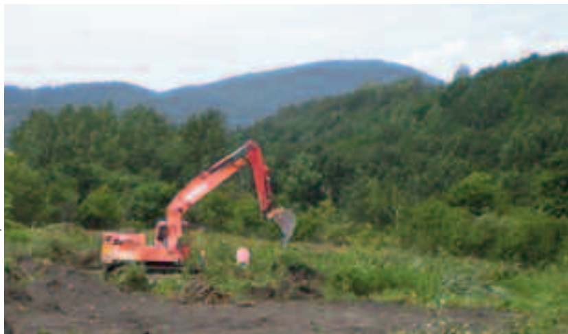
W tym miejscu stanie galeria, lipiec 2008
