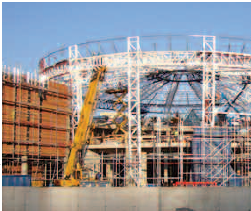
Montaż konstrukcji stalowych, grudzień 2009
