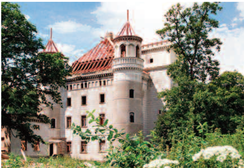
Odbudowa pałacu w Wojanowie
