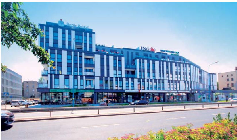
Legnica, budynek MPoint
