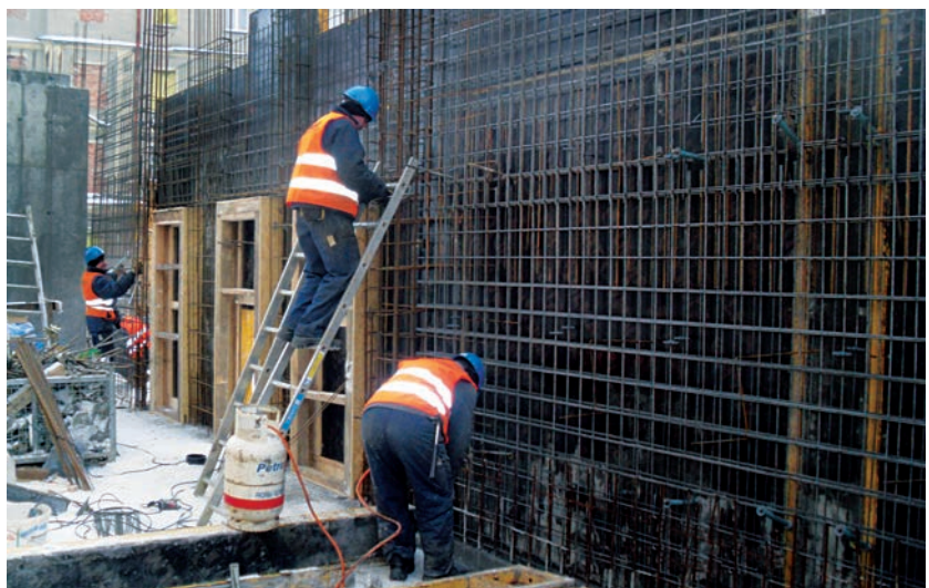
Zbrojenie ścian w budynku B, grudzień 2010
