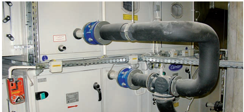
Afrykarium, podłączenie instalacji chłodu do centrali wentylacyjnej, marzec 2014
