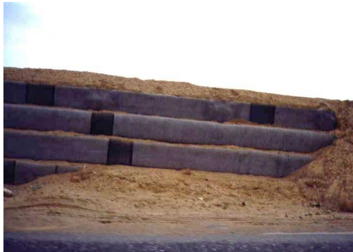
Rys. 28. Widok fragmentu dobrze uformowanego lica muru zbrojonego
