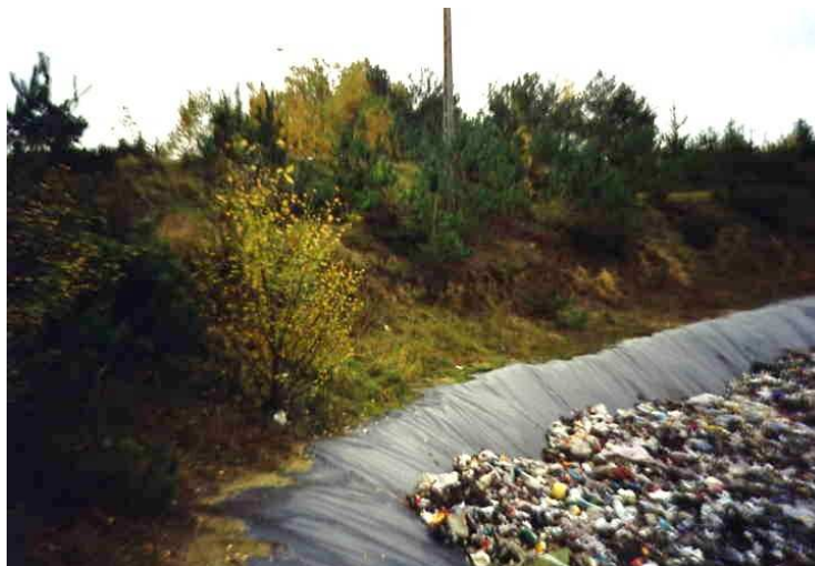
Rys. 15. Niedopuszczalne składowanie odpadów bezpośrednio na geomembranie
