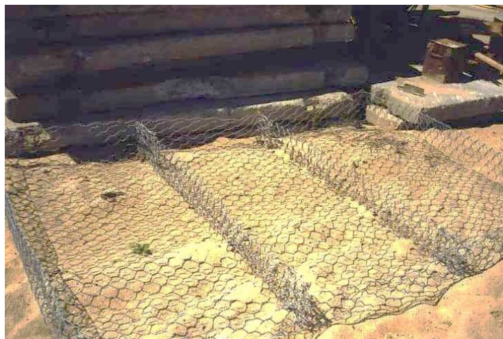
Rys. 43. Układanie koszy gabionowych bez zastosowania geosyntetyków
