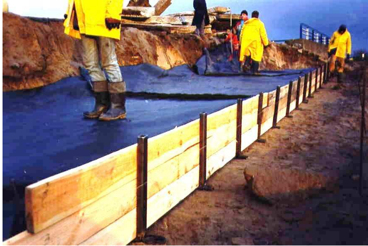
Rys.27. Wykonanie pierwszej warstwy muru zbrojonego z zawinięciem pasm geosyntetyku
