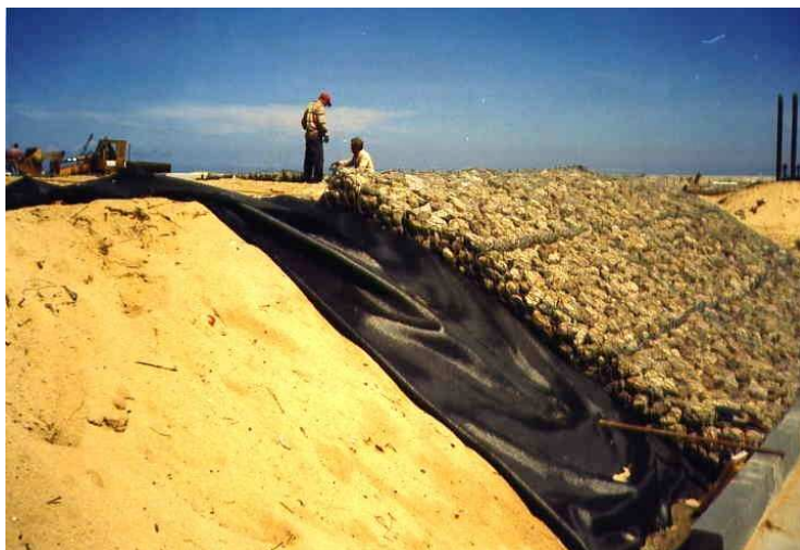
Rys. 44. Zabezpieczenie skarpy przed erozją poprzez ułożenie geotkaniny
