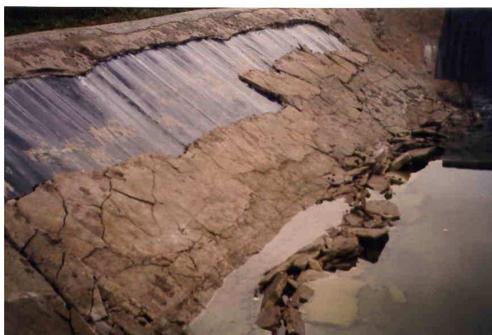
Rys. 11. Zsuw warstw okrywających geomembraną na skarpie
