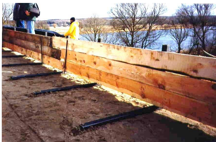
Rys. 26. Prawidłowe tworzenie lica muru zbrojonego – ustawianie przestrzennych szalunków
